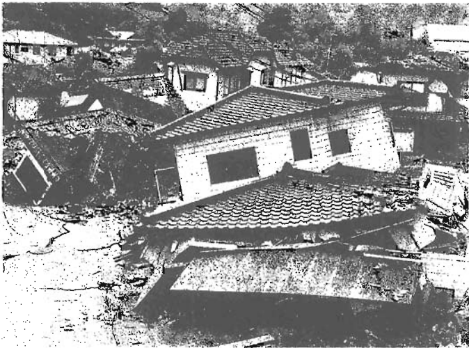
熊本地震で1階が押しつぶされた住宅＝4月16日、熊本県益城町(撮影・丸岡裕美)
